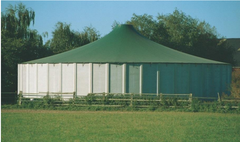
CENO-Hochsilodach Mit nachspannbarer Mittelstütze (Schneelast 110kg, bzw. 150kg/m 2 )
